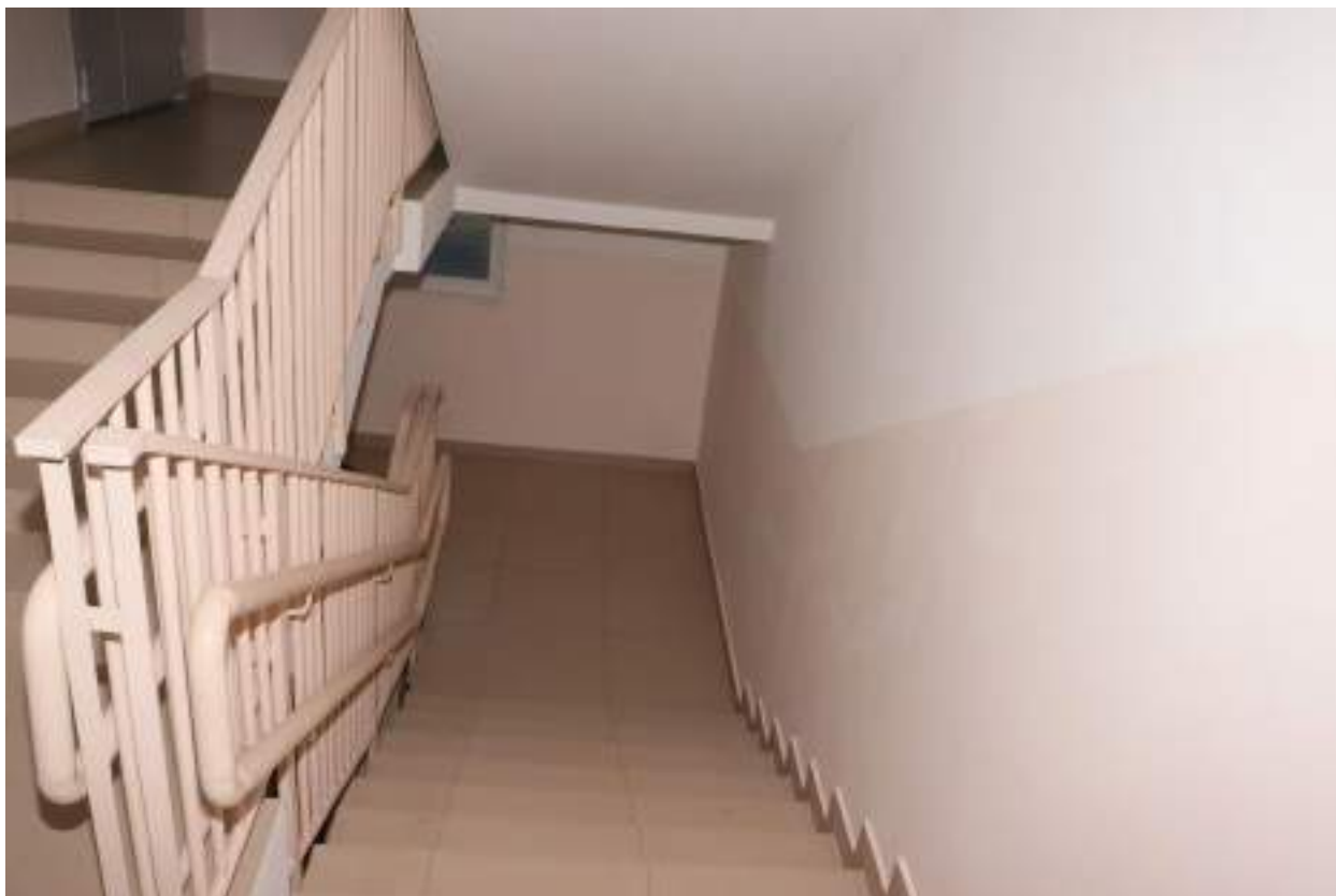
3.3 Лестница внутри здания
