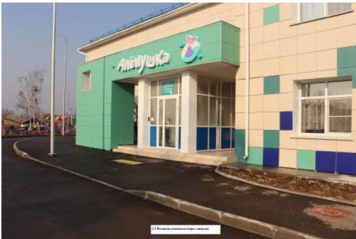
2.3. Входная площадка перед дверью
